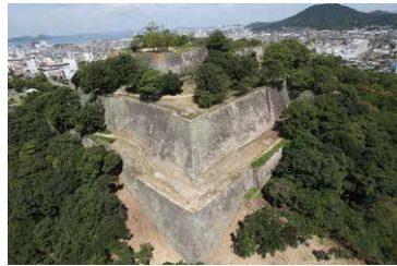
ほうらくまえ 崩落前
